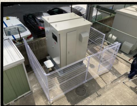
▲キュービクル新設
