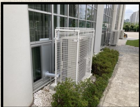
▲基礎工事・室外機ガード設置
